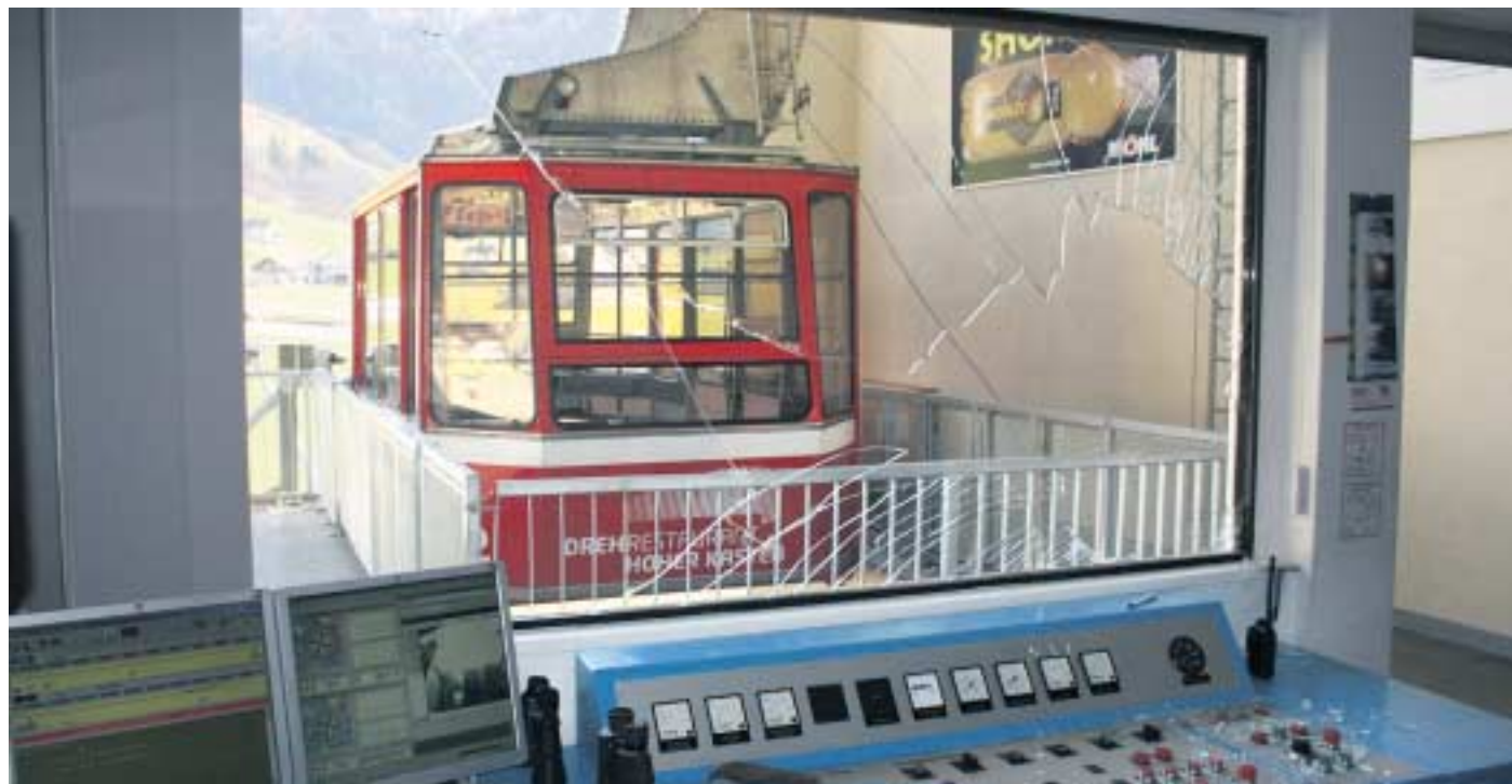
Blick aus der Betriebsleitzentrale: Beim Aufprall der Seilbahn auf die Talstation in Brülisau wurde ein Mitarbeiter schwer verletzt.
